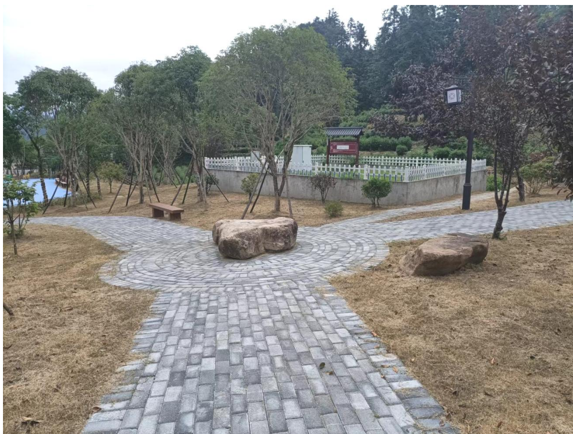
洪墩村污水处理设施实景图
